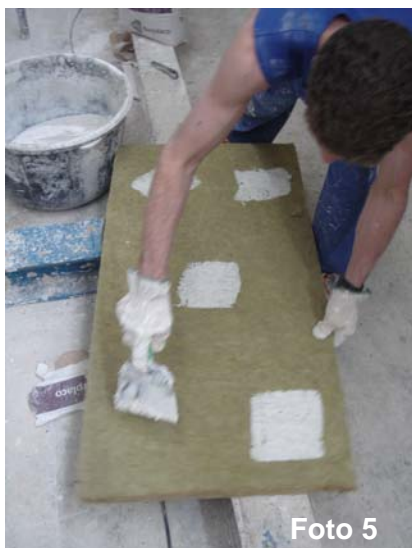
Fotos 5 y 6: Montaje de lana de roca
