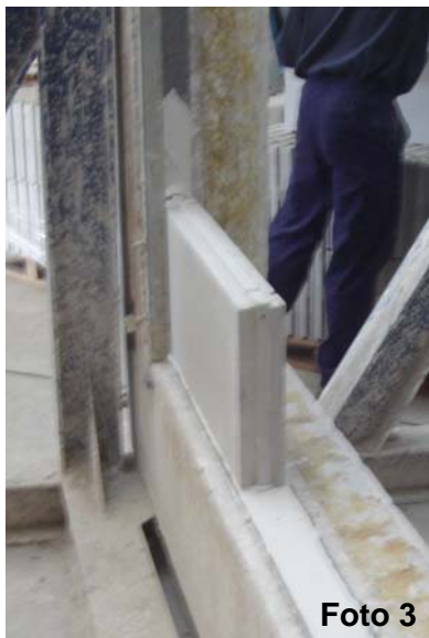
Fotos 3 y 4: Construcción de fábrica de bloque “Lateroyeso 8 LD” sobre banda perimetral
