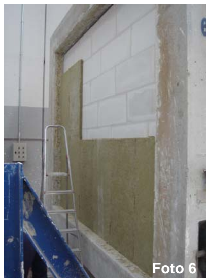
Fotos 5 y 6: Montaje de lana de roca
