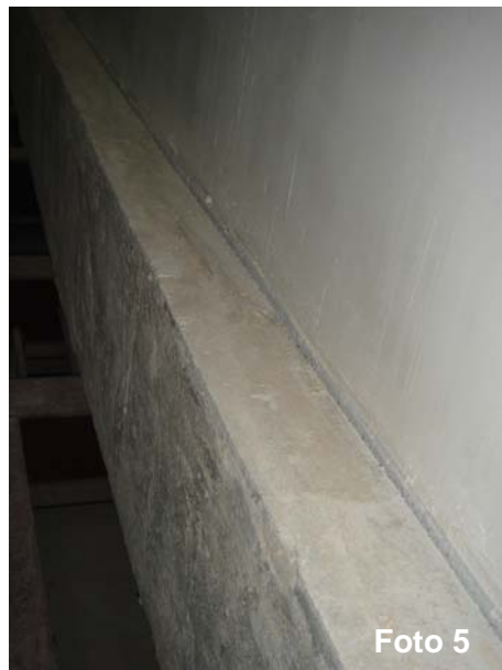
Foto 5: Detalle de unión inferior fábrica-marco portamuestras
