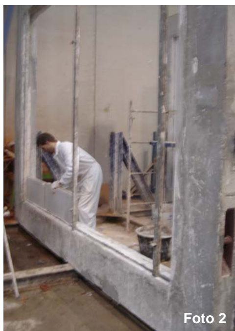
Fotos 2 y 3: Construcción de fábrica de bloque “Lateroyeso 8 LD” sobre banda EEPS inferior
