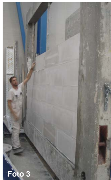
Fotos 2 y 3: Construcción de fábrica de bloque “Lateroyeso 7 LD” sobre banda EEPS inferior
