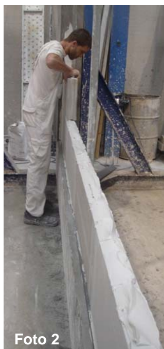
Fotos 2 y 3: Construcción de fábrica de bloque “Lateroyeso 7 LD” sobre banda EEPS inferior
