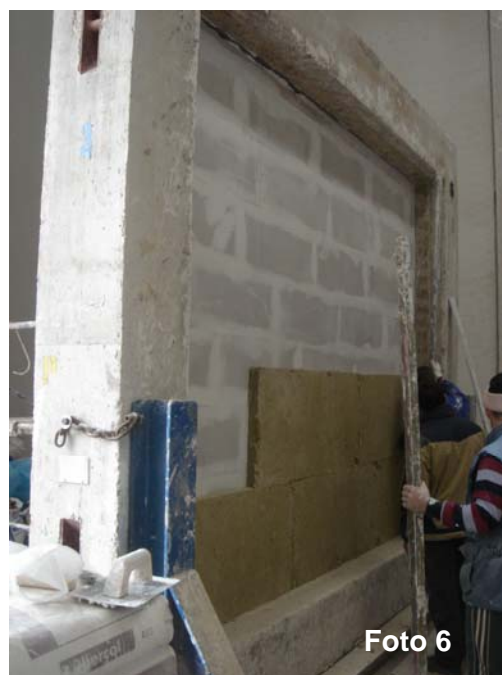
Fotos 5 y 6: Montaje de lana de roca
