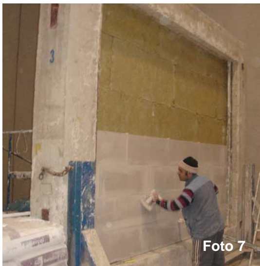
Foto 7: Construcción de fábrica de bloque "Lateroyeso 6 LS" sobre banda perimetral
