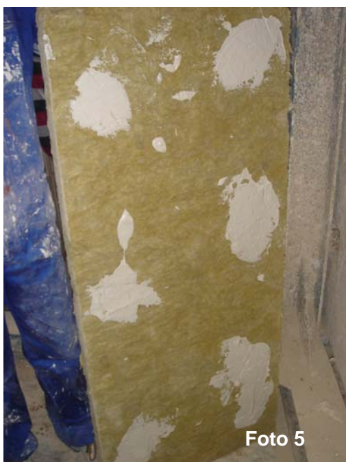
Fotos 5 y 6: Montaje de lana de roca
