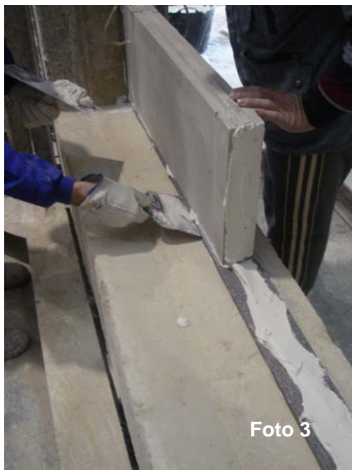
Fotos 3 y 4: Construcción de fábrica de bloque “Lateroyeso 7 LD” sobre banda perimetral
