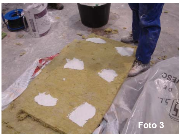
Fotos 3 y 4: Montaje de lana de roca
