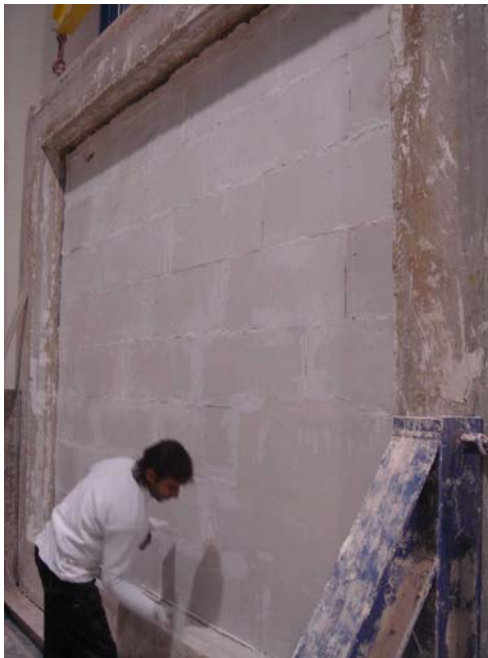
Foto 2: Construcción de primera fábrica de bloque “Lateroyeso 6 LS” sobre banda perimetral
