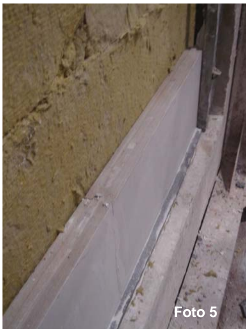
Fotos 5 y 6: Construcción de segunda fábrica de bloque “Lateroyeso 6 LS” sobre banda perimetral
